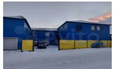
Автосервис, 700 м 2 Читинский переезд 9 000 000 ₪ 12 857 ₪ за м 2 Тракторная ул., 16 р-н Железнодорожный 1 неделю назад
