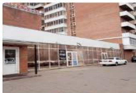
Помещение на Элеваторе 144.8 м 2
